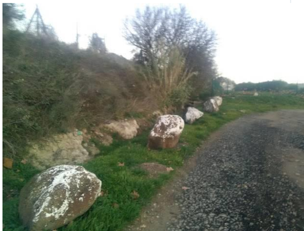
Figure 9 : Fossé en terre en pied de talus de la parcelle AI 289, comblé dans le cadre du présent projet
